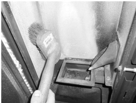
**Figura 105 – Limpeza da vermiculite**
