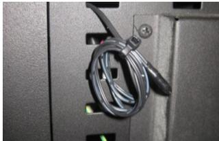
**Figura 95 – Sonda temperatura ambiente**
