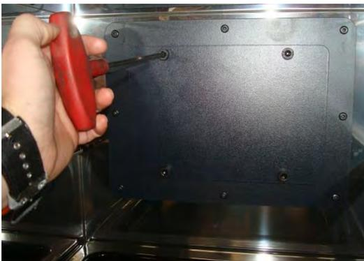
*Figura nº16 - Acceso a los tornillos para retirar la tapa de la escotilla*
